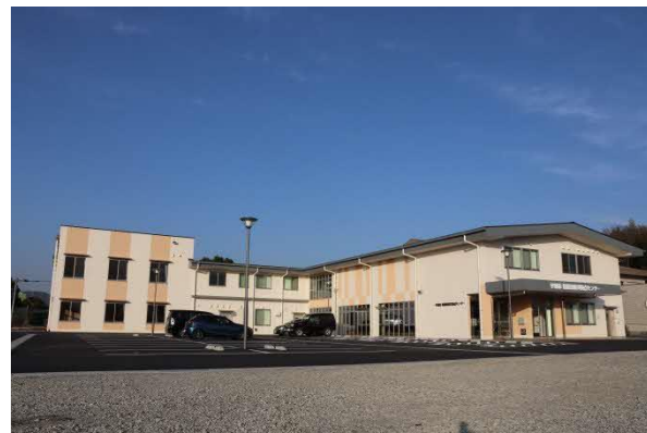
松橋防災拠点センター東
